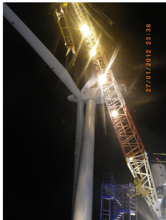
Installation der Rotorblätter
